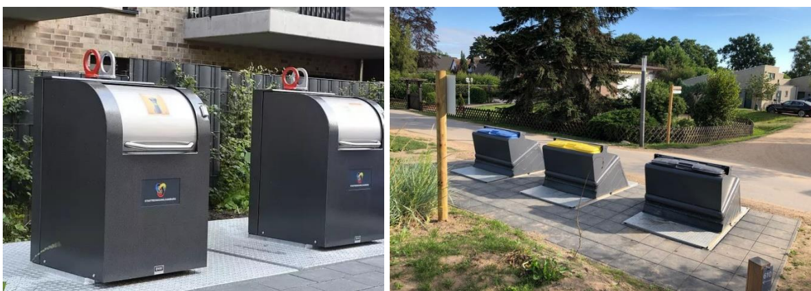
Abbildung 31: Unterflurcontainer – Leerung links mit Abrollkipper und Kran, rechts mit Seitenlader
