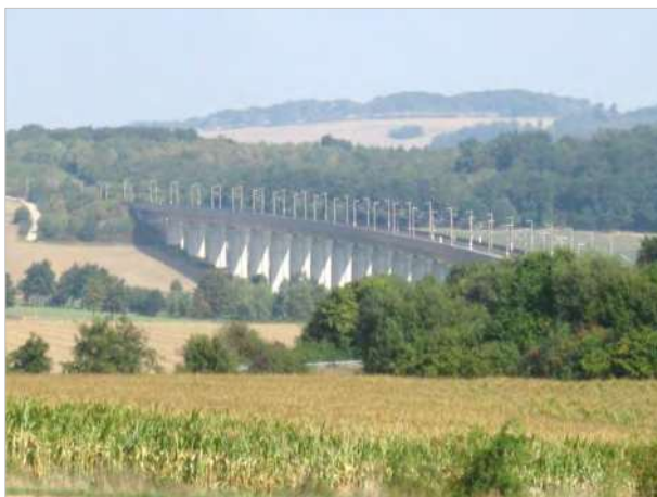
Abb. 44: Brücke der ICE-Trasse über Auetalniederung
