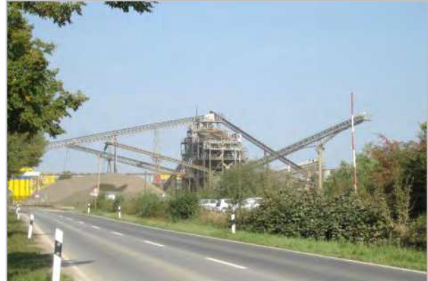
Abb. 43: Abbaugelände mit Förderbändern und Straße an der „Northeimer Seenplatte“
